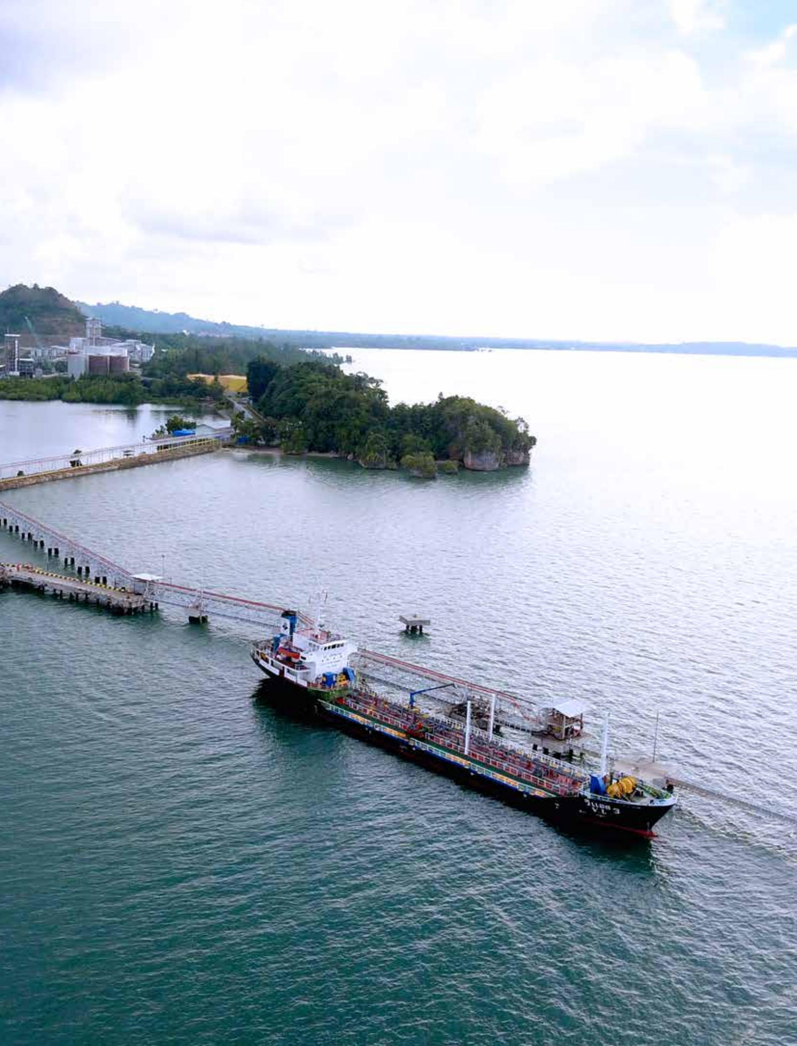
■ Pelabuhan Tanjung Bakau yang dioperasikan oleh Perusahaan di Kabupaten Mamuju Utara, Sulawesi Barat Tanjung Bakau Port operated by Company in Mamuju Utara Regency, West Sulawesi
