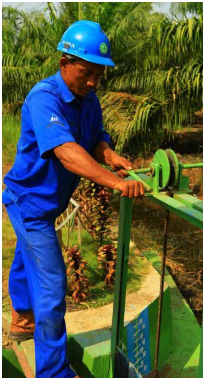
Pintu air berfungsi mengatur aliran air untuk mempertahankan ketinggian permukaan air di lahan gambut
